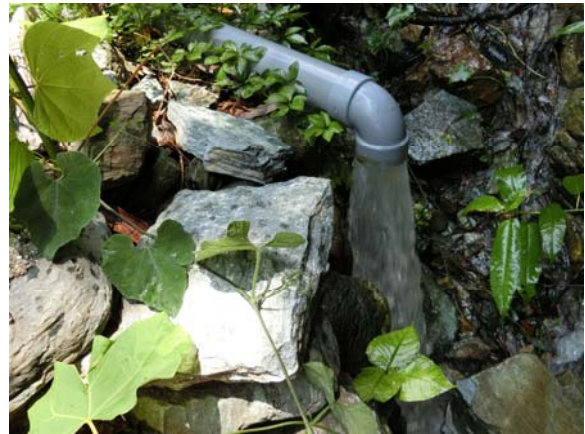
写真-3 横ボーリング工の排水状況
