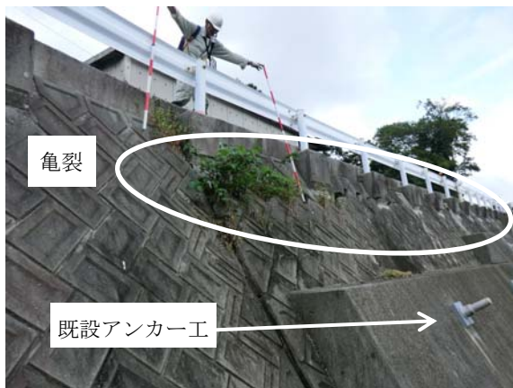
写真-4 Eブロック頭部
