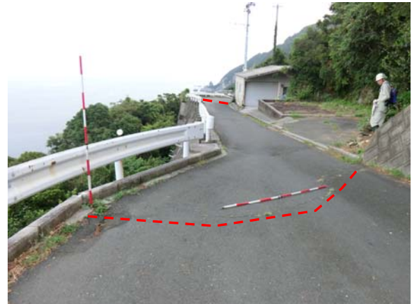
写真-5 Eブロック頭部
