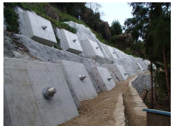
写真-6 アンカー工竣工状況
