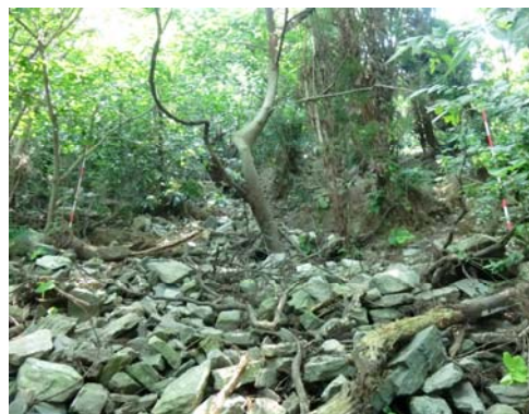
写真-2 C-5 ブロック末端付近 湧水を伴う表層崩壊
