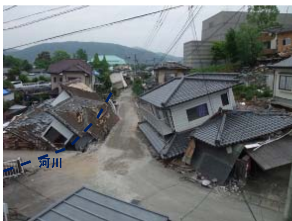
写真-7 河川に向かって家屋が倒れ込む
