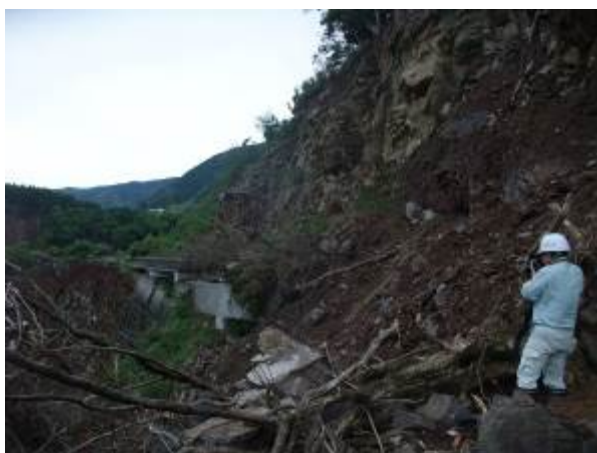
写真-4 岩盤崩壊による戸下大橋の落橋
