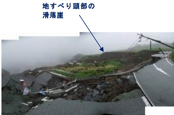
写真-2 地すべり（立野駅東南東方斜面）
