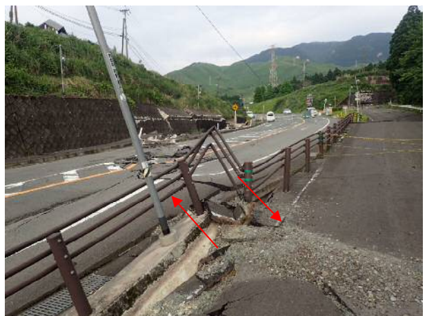
写真-5 ダム変状箇所から県道28号へ続く地表地震断層 ガードフェンスに右横ずれ変位が読み取れる
