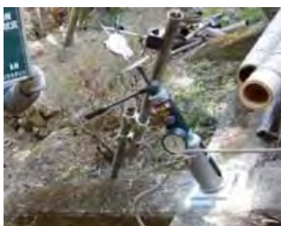
写真.4 ボルトジャッキ試験状況
