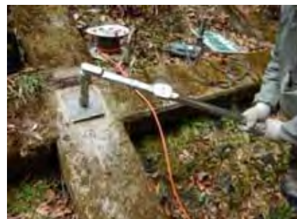
写真.3 トルクレンチ測定状況
