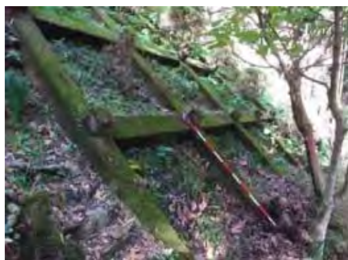
写真-1 のり面状況
