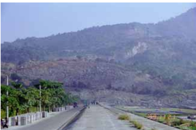
写真 - 8 周辺斜面の被害状況
