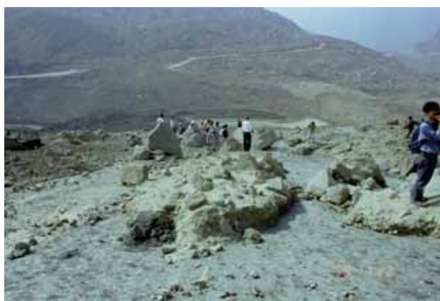
写真 - 6 すべり面中腹から下を望む
