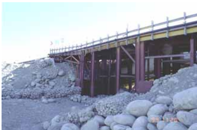
写真 - 8 応急復旧の状況
