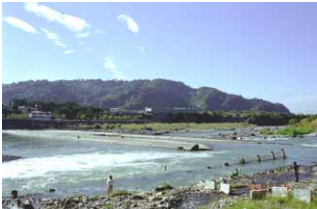
写真 - 5 ダム周辺の状況(その2)
