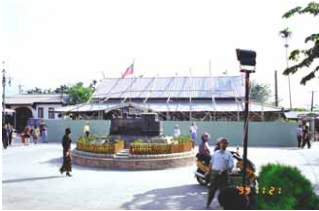
写真 - 1 集集駅の被害(その1)
