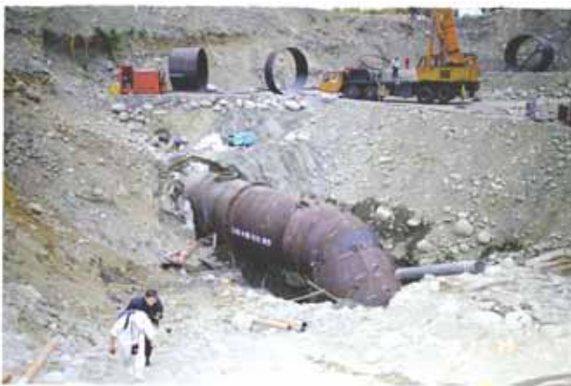
写真 - 6 導水路トンネルの復旧状況
