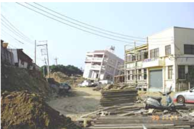
写真 - 6 周辺建物の被害状況 (その1)
