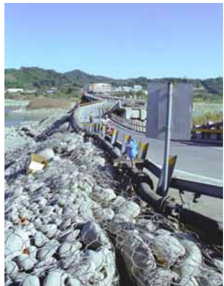
写真 - 7 ライフライン(水道管) の復旧状況
