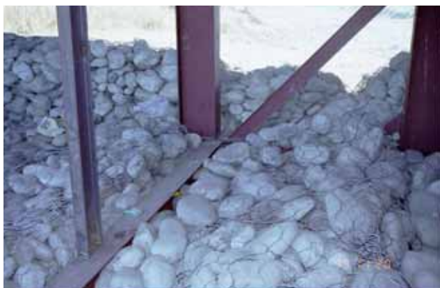
写真 - 9 仮栈橋の基礎の状況
