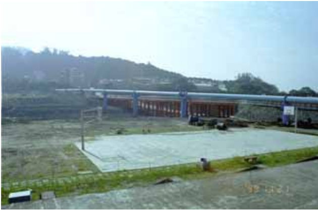
写真 - 5 復旧状況
