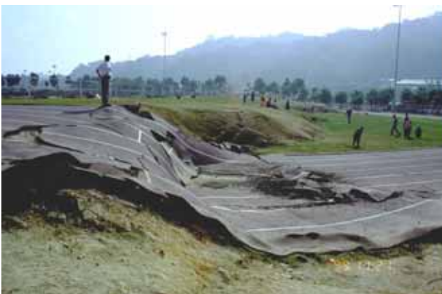
写真 - 7 地表地震断層(その3)
