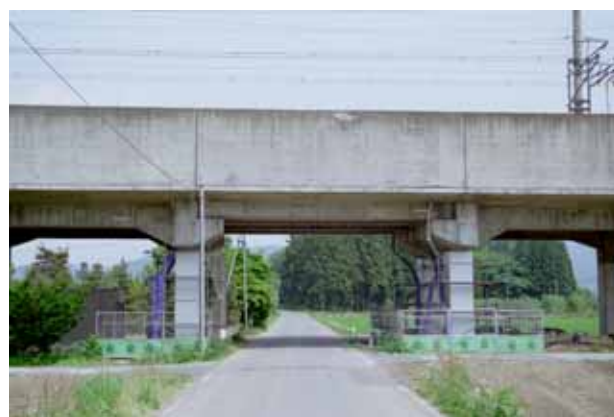
Pho-2 橋脚の復旧状況．エポキシ樹脂の注入と鋼板補強などによる補修・補強を実施．
