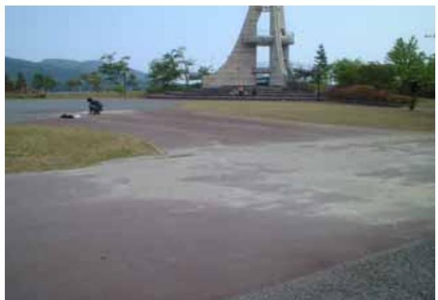
Pho-8 サン・アンドレス公園内の噴砂 . 舗装面では沈下や波打ちの被害を伴う .
