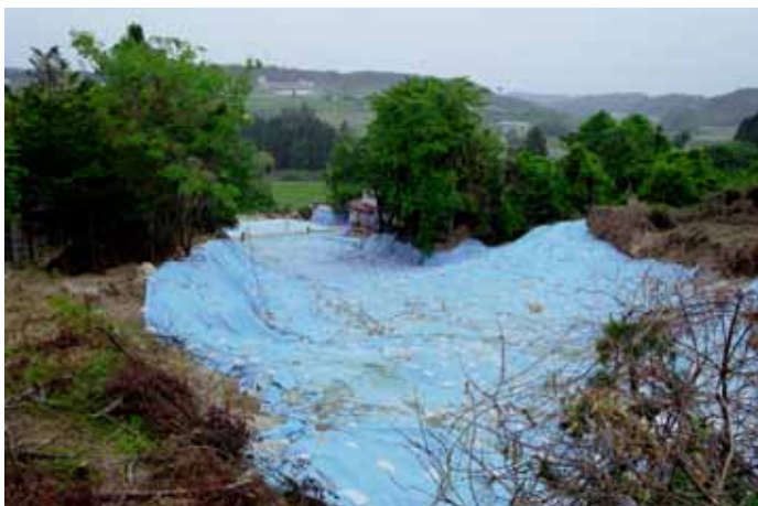
Photo-3 崩壊地（ブルーシート）を上方より望む。 崩壊した斜面の割に緩い。
