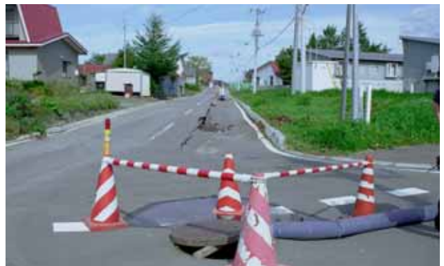
写真 - 20 同左 仮設ポンプにより排水中
