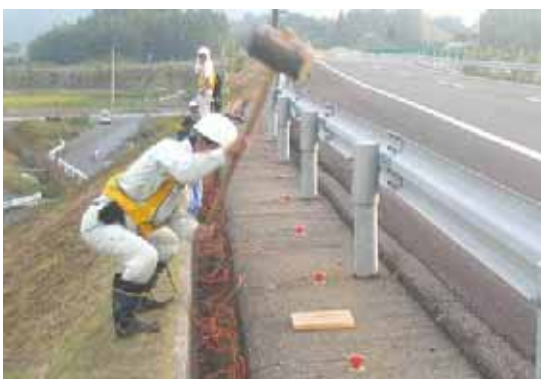
写真-1 表面波探査の状況
