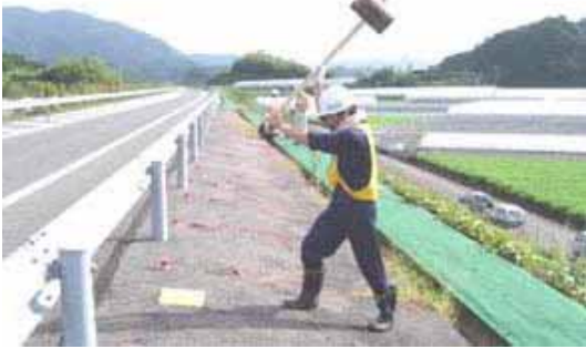
写真-1 表面波探査の状況
