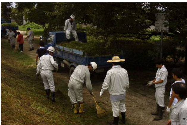
草刈後の草の収集，詰込作業（1）
