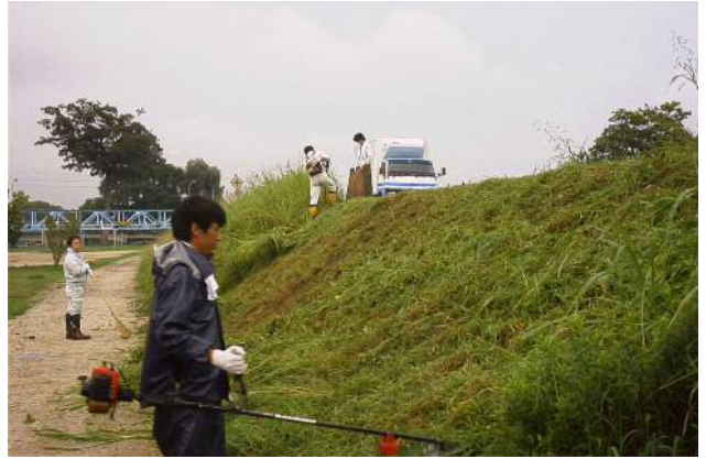
法面の草刈状況
