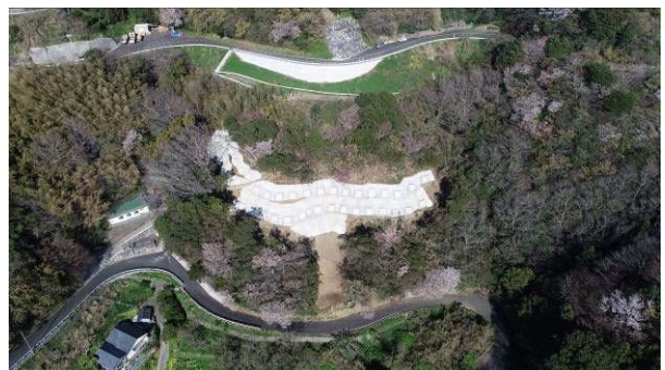
写真-3 対策工施工後の全景
